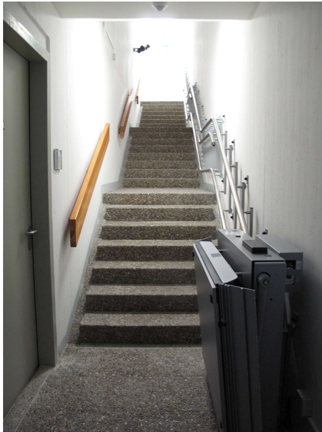
Foto Treppenlift (Hinweis Treppenhaus vor Sanierung, d.h. nur Treppenlift und Stufen sind noch gleich)
